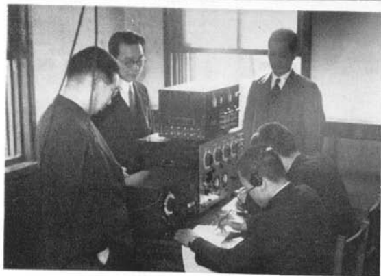
↑ 豊原支局 (樺太) の通信施設
