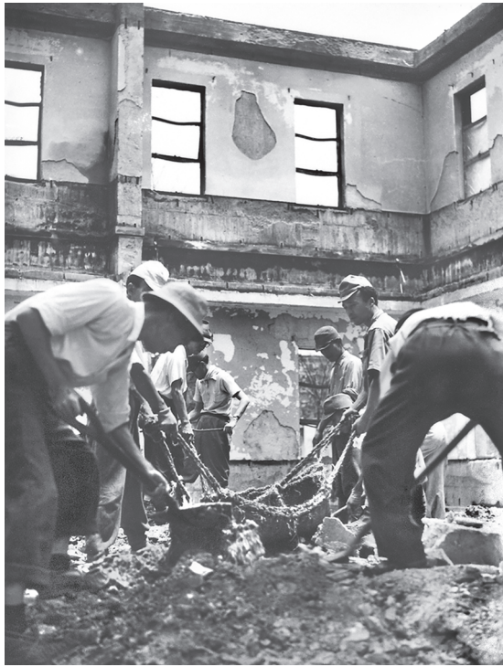
空襲で焼けた同盟通信別館跡地を片付ける同盟の建設隊＝1945（昭和20）年7月上旬
