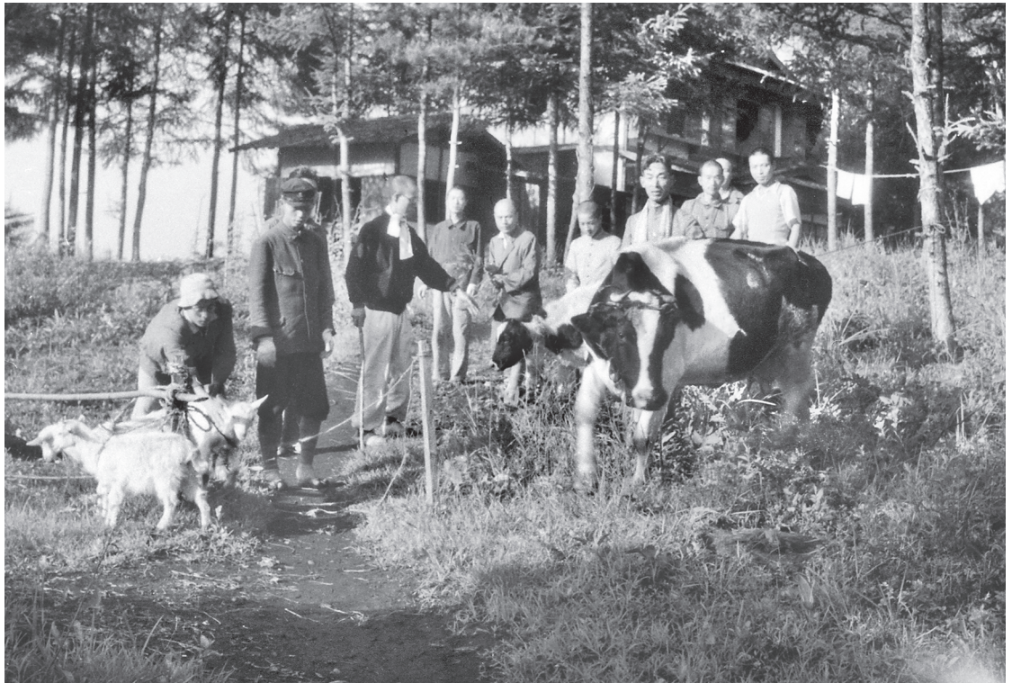
長野県・蓼科高原に建設中の同盟通信蓼科農場=1945(昭和20)年8月
